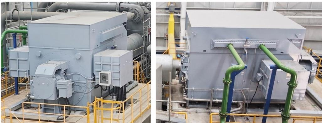
TMEiC研发的6极大型同步电机（输出功率：48.4 MW）
