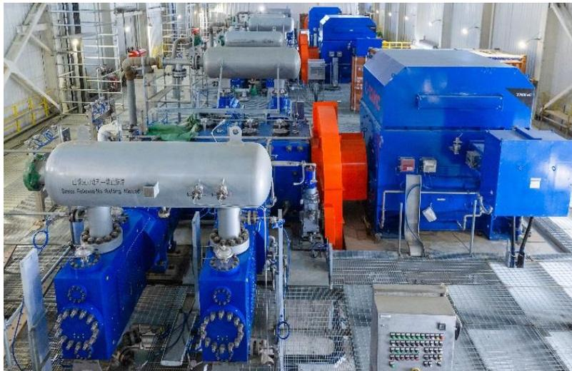
往复式压缩机（左）和 TMEIC 制造的同步电机（右）
