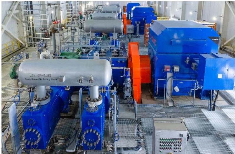
往复式压缩机（左）和 TMEIC 制造的同步电机（右）
