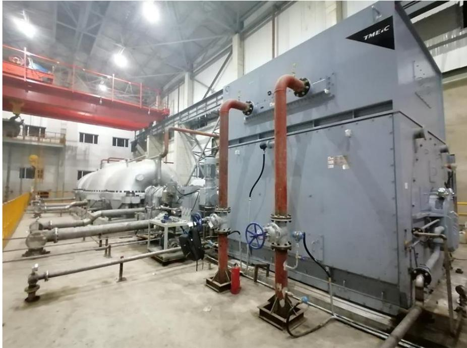
投运中的 4P-10kV 38MW 异步电机 现场
