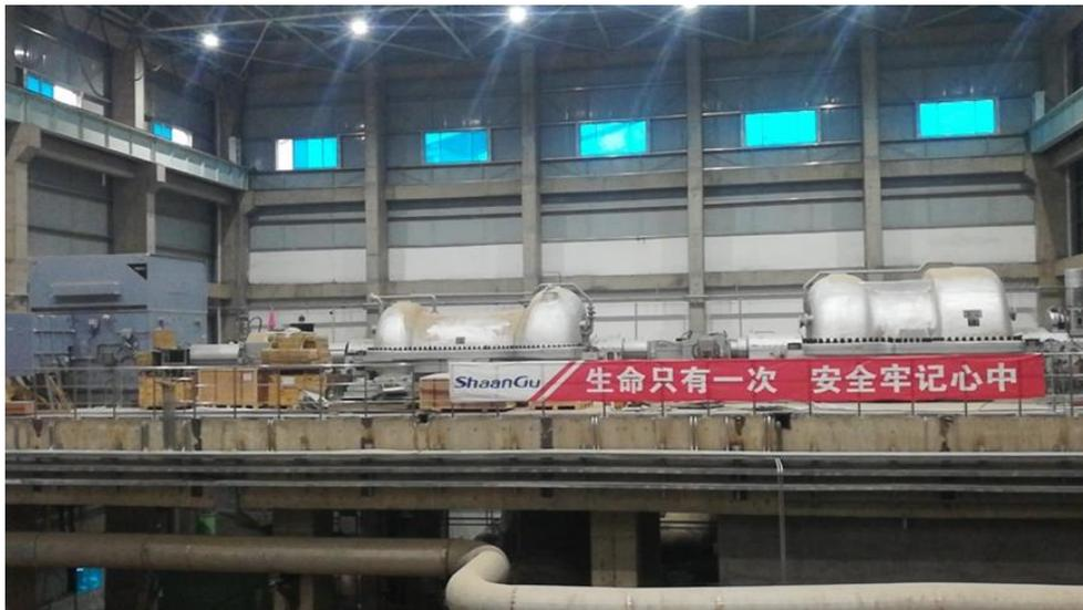
首套 4P-10kV 35MW 异步电机运行现场
