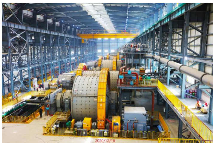
玉龙一期项目现场
