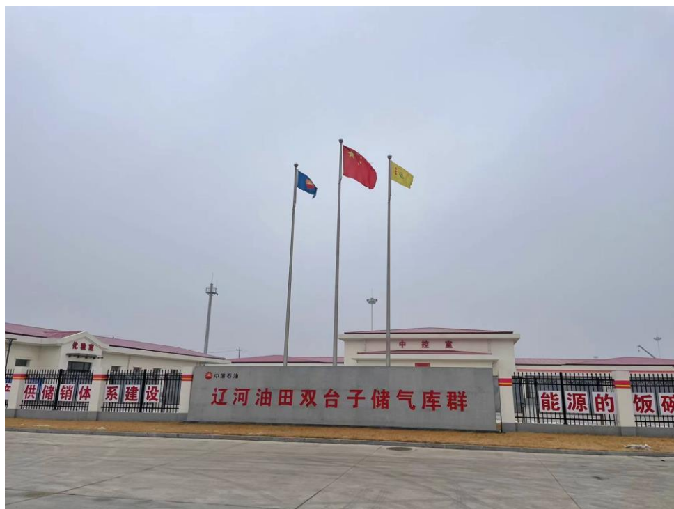
辽河油田双台子储气库群
