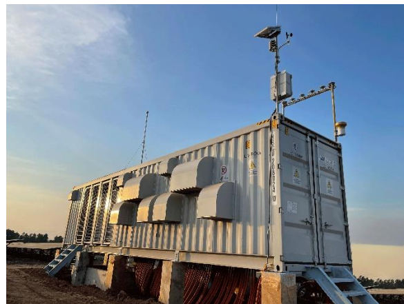
TMEIC Solar Ware Station @Loc Ninh 4&5 光伏电站
