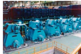
Motores principales Planta de laminación de metales
